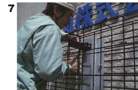
在鐵架上固定植栽框架「Pixel Frame」(固定基礎鐵架的設計依現場變化)
