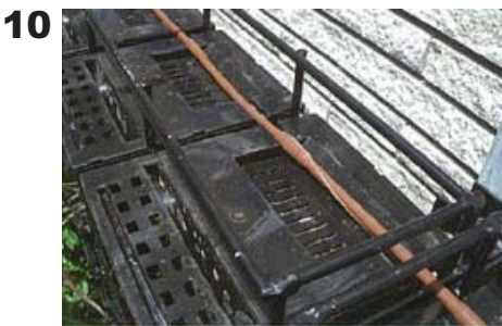
鋪設「自動澆水管」(每6段植栽籃鋪設1列澆水管)
