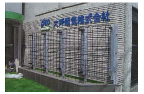
植栽框架「Pixel Frame」固定完成
