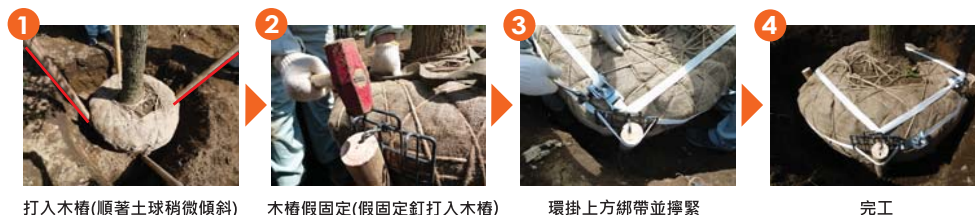
打入木樁(順著土球稍微傾斜)
