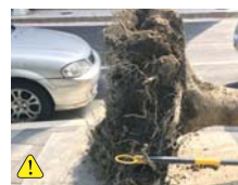
土球破裂不完整禁用地下支架
