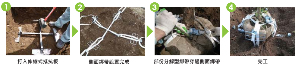
打入伸縮式抵抗板
