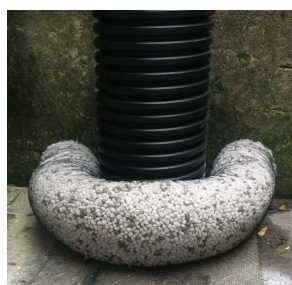
■排水口檢修蓋的外圍捲上酸素管的外觀。
