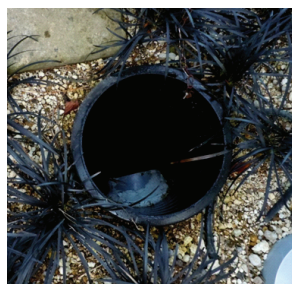
■打開排水口檢修蓋後排水口的外觀
